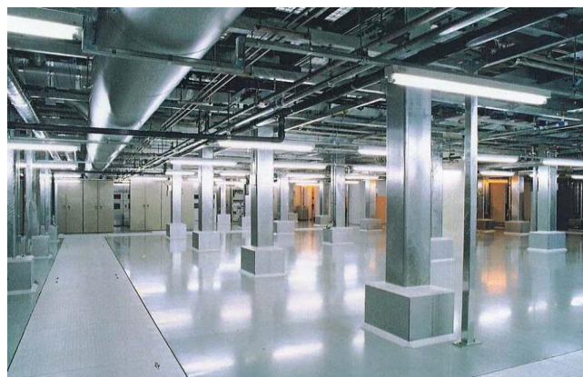
●ユーティリティエリア (B1F, 3F) 各装置の補機類が設置されます。
